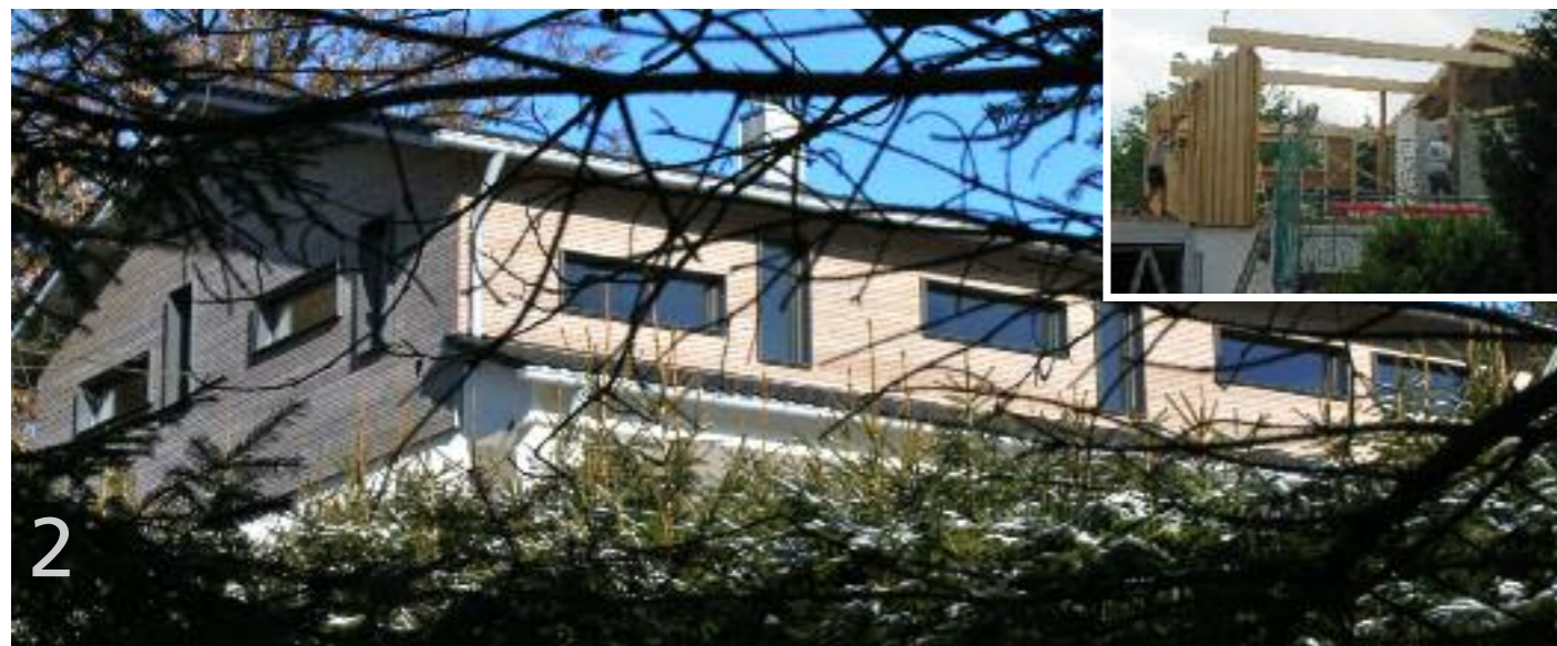
2 - Das Dach des 1967 erbauten Hauses verfügte über nahezu keinen Kniestock. Deswegen wurde ein neues Holzdach aufgesetzt – innerhalb von nur drei Tagen.
